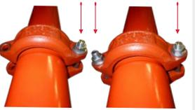
**10** Serrez les boulons alternativement à l'aide d'une clé à chocs et d'une clé à douille appropriée, jusqu'à ce que l'accouplement soit complètement fermé. Pour une bonne étanchéité, respectez les couples de serrage des boulons (voir tableau). Un couple trop important ne va pas améliorer l'étanchéité de l'accouplement ; au contraire, il peut endommager les boulons et/ou le carter et peut même entraîner la déconnexion des tuyaux. Un couple trop faible entraînera des fuites.
