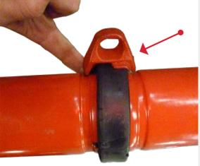
**8** Introduisez un boulon à travers le carter. Veillez à ce que la tête du boulon s'insère parfaitement dans le carter.
