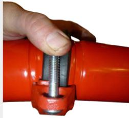
**9** Placez le deuxième carter sur le boulon et serrez l'écrou à la main sur le boulon. Placez ensuite le deuxième boulon et serrez-le à la main.
