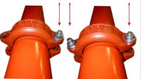
**10** Serrer alternativement les boulons avec une clé à chocs avec une douille adaptée jusqu'à ce que le raccord soit entièrement fermé. Toujours observer les couples de serrage des boulons pour obtenir une bonne étanchéité (voir le tableau). Un couple de serrage trop important n'améliore pas l'étanchéité du raccord. Au contraire, il peut endommager les boulons et/ou boîtiers et peut même être la cause d'une rupture des tuyaux. Un couple de serrage trop petit entraînera des fuites.
