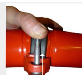
**9** Placer le second boîtier sur le boulon et serrer l'écrou avec les doigts sur le boulon. Poser ensuite le second boulon et le serrer avec les doigts.
