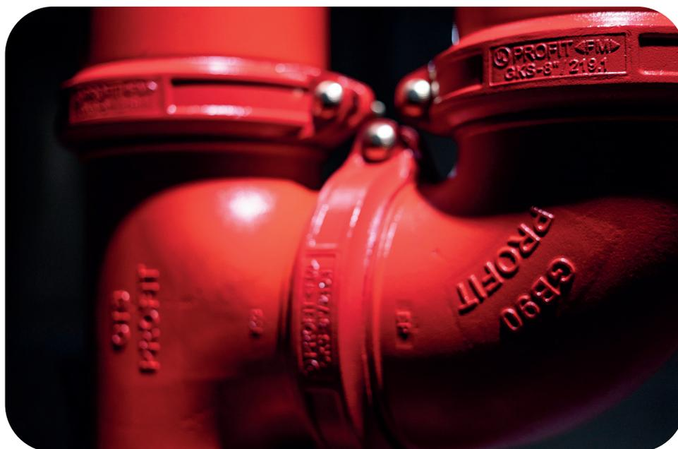
\*Les raccords mécaniques n'ont pas la marque CE. Nous recommandons l'utilisation dans la catégorie SEP de la PED.
